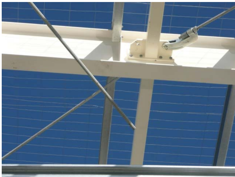
Εικ. 14 Θράση συστήματος σύνδεσης οριζόντιων συνδέσμων. Ο συγκεκριμένος τύπος σύνδεσης αποτελεί πατέντα και έχει δοκιμαστεί εργαστηριακά μόνο σε στατικές φορτίσεις, [2,3]. Κατά κάποιο τρόπο η θραύση ήταν αναμενόμενη.
