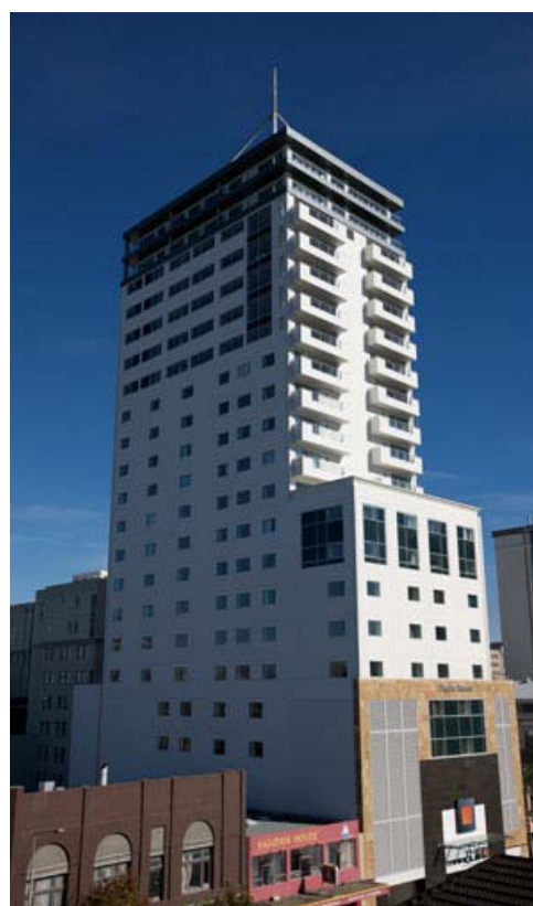
Εικ. 13α Pacific Residential Tower. Το υψηλότερο κτίριο στο Christchurch. Ο φέρον οργανισμός αποτελείται από πλαίσια κάμψης, πλαίσια με έκκεντρους συνδέσμους, κατάλληλα τοποθετημένους, και σύμμικτες πλάκες. Ο φορέας έχει διαστασιολογηθεί με βάση το κριτήριο των μετακινήσεων, με χαμηλό επίπεδο πλαστιμότητας ( \mu = 1.50 ), [3], εάν και ο Νεοζηλανδικός κανονισμός για το αντίστοιχο τύπο φορέα ορίζει δείκτη συμπεριφοράς \mu = 4.0
