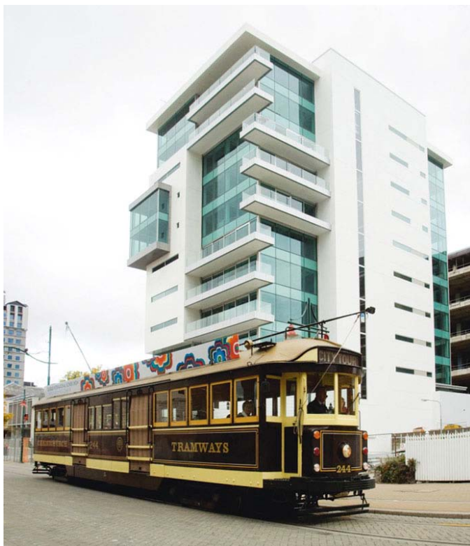
Εικ. 13β The Club Tower κτίριο 12 ορόφων με έτος αποπεράτωσης το 2009. Ο φέρον οργανισμός αποτελείται από πλαίσια κάμψης, πλαίσια με έκκεντρους συνδέσμους, και σύμμικτες πλάκες. Τα πλαίσια κάμψης έχουν διαστασιολογηθεί με βάση το κριτήριο των μετακινήσεων, με χαμηλό επίπεδο πλαστιμότητας ( \mu= 1.25 ), ενώ τα πλαίσια με έκκεντρους συνδέσμους με δείκτη πλαστιμότητας \mu= 4.0 , [3]
