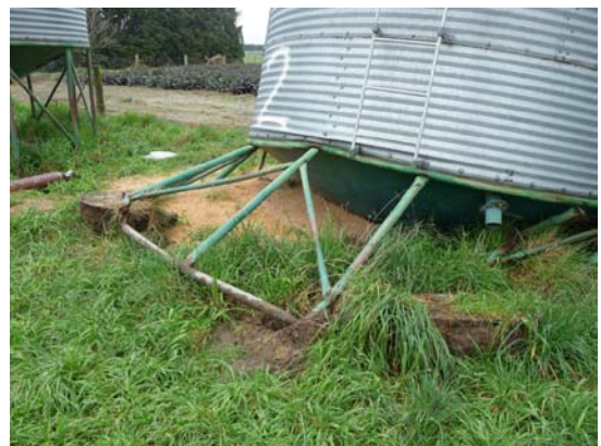
Εικ. 20 Καταρρεύσεις μεταλλικών σιλό [2]
