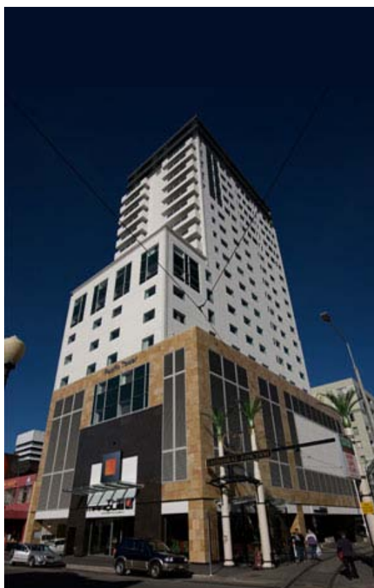
Εικ. 13α Pacific Residential Tower. Το υψηλότερο κτίριο στο Christchurch. Ο φέρον οργανισμός αποτελείται από πλαίσια κάμψης, πλαίσια με έκκεντρους συνδέσμους, κατάλληλα τοποθετημένους, και σύμμικτες πλάκες. Ο φορέας έχει διαστασιολογηθεί με βάση το κριτήριο των μετακινήσεων, με χαμηλό επίπεδο πλαστιμότητας ( \mu = 1.50 ), [3], εάν και ο Νεοζηλανδικός κανονισμός για το αντίστοιχο τύπο φορέα ορίζει δείκτη συμπεριφοράς \mu = 4.0
