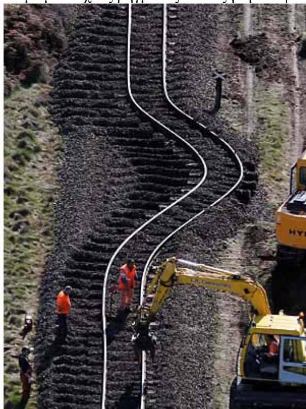
Φώτο 8. Παραμόρφωση εδάφους
