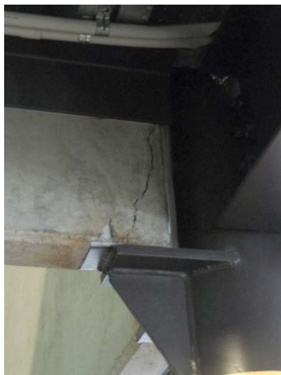
Εικ. 15 Westfield Riccarton Mall. Θράση προκατασκευασμένων δοκών στην θέση στήριξης. Κτίριο με φέροντα οργανισμό από προκατασκευασμένα πάνελα και μεταλλικό σκελετό με έκκεντρους συνδέσμους, [1],[2]
